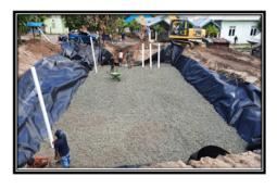
2018 年 9 月に発生したインドネシア・スラウェシ島地震・津波により、約 17 万人以上が避難を余儀なくされている。しかし、避難先の定住用住居は上水道等のインフラ整備が進んでおらず、今回外務省の日本 NGO 連携無償資金協力(N連)に採択された企業と連携し、雨水を活用した自然浄水機能を持つ雨水貯水地下タンク「ためとっと」の施工指導を、現地とリモートで行い貯水量 100 トン 4 基の設置が完了した。
